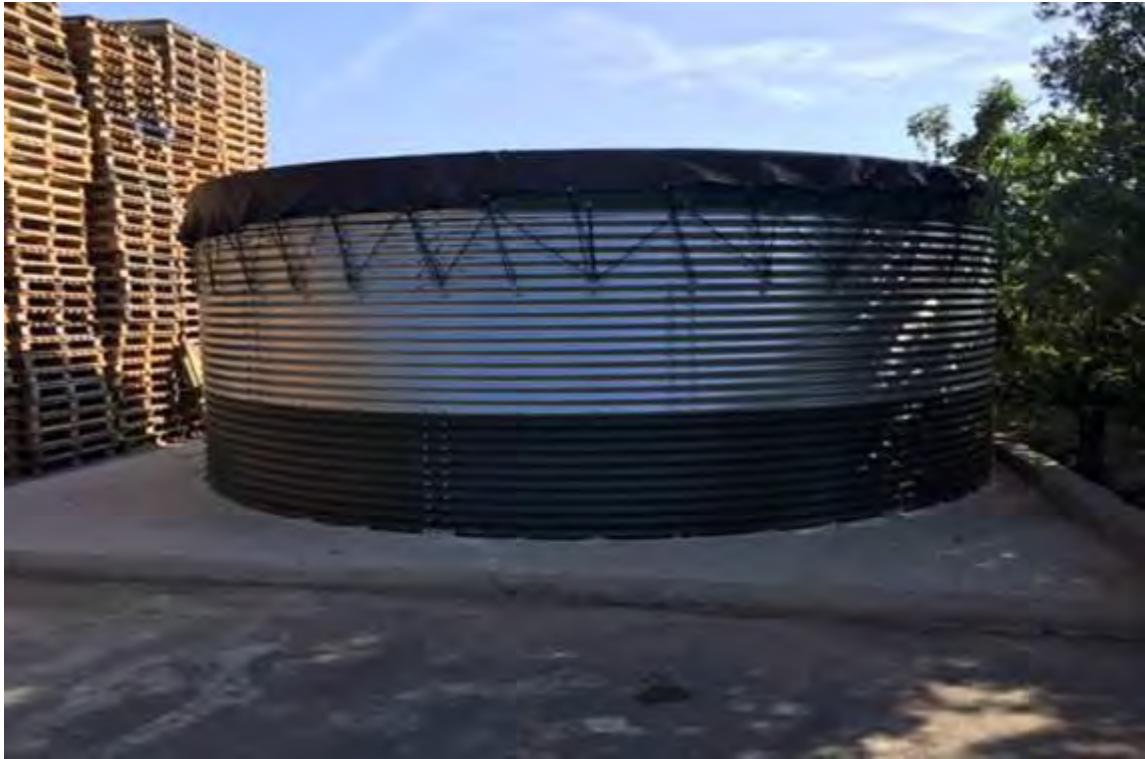
Figura 1. Exemple de dipòsit de xapa
