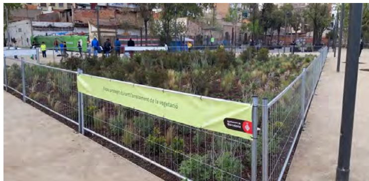
Tanques de protecció parterres durant el període d'arrelament de la vegetació
