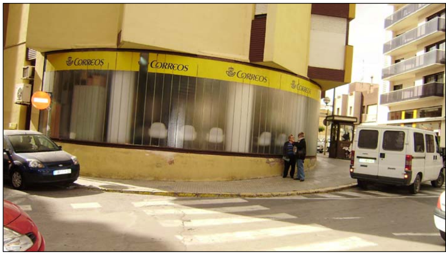
VISTES CARRER VERGE DE MONTSERRAT 07
