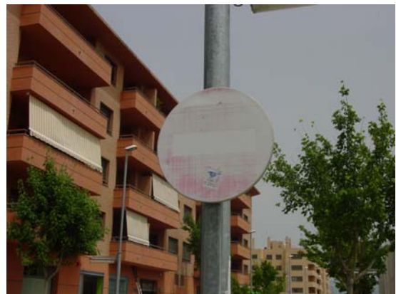
Senyal en estat deficient
